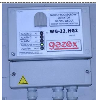
DETEKTOR TLENKU WĘGLA SYSTEMU GAZEX
