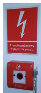
PRZYCIŚK POŻAROWEGO ODŁĄCZNIKA PRĄDU
