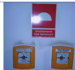
PRZYCISKI STERUJĄCE ODDYMIANIEM KLATEK SCHODOWYCH
