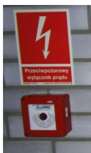
PRZYCIŚK POŻAROWEGO ODŁĄCZNIKA PRĄDU
