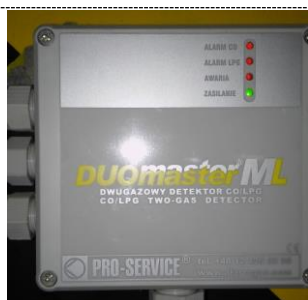
DETEKTOR TLENKU WĘGLA / GAZU LPG SYSTEMU PRO-SERVICE
