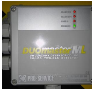
DETEKTOR TLENKU WĘGLA / GAZU LPG SYSTEMU PRO-SERVICE
