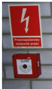
PRZYCISK POŻAROWEGO ODŁĄCZNIKA PRĄDU
