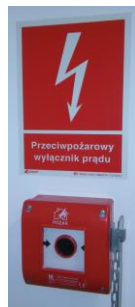
PRZYCISK POŻAROWEGO ODŁĄCZNIKA PRĄDU
