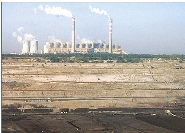
Rysunek 1 Półkowy postęp zdejmowania nadkładu i eksploatacji węgla w KWB Bełchatów
